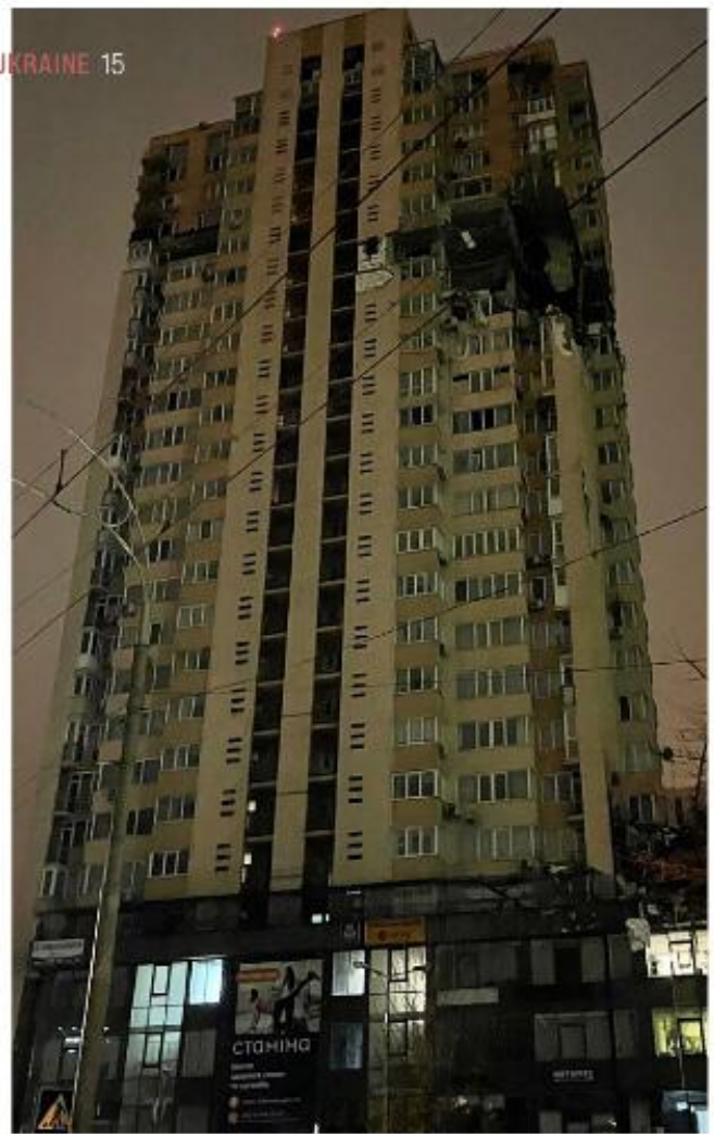
In Kiew werden immer wieder Hochhäuser von russischen Raketen getroffen.
